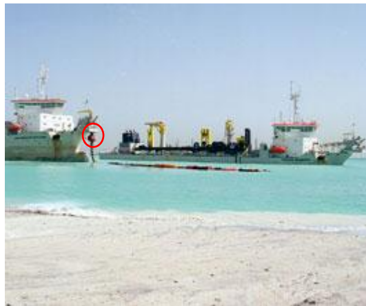
Figura 9.17 – Conexión de la draga a tubería flotante
