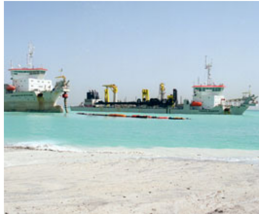
Figura 9.15 – Conexión de la draga a tubería flotante
