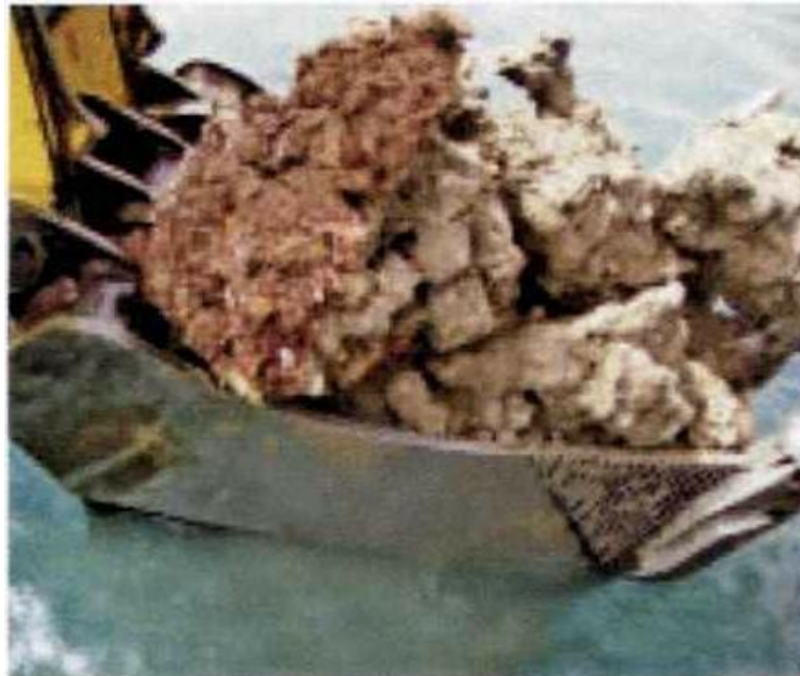
Figura 8.24 – Bloques de coral de hasta 2 m excavados por la retro
