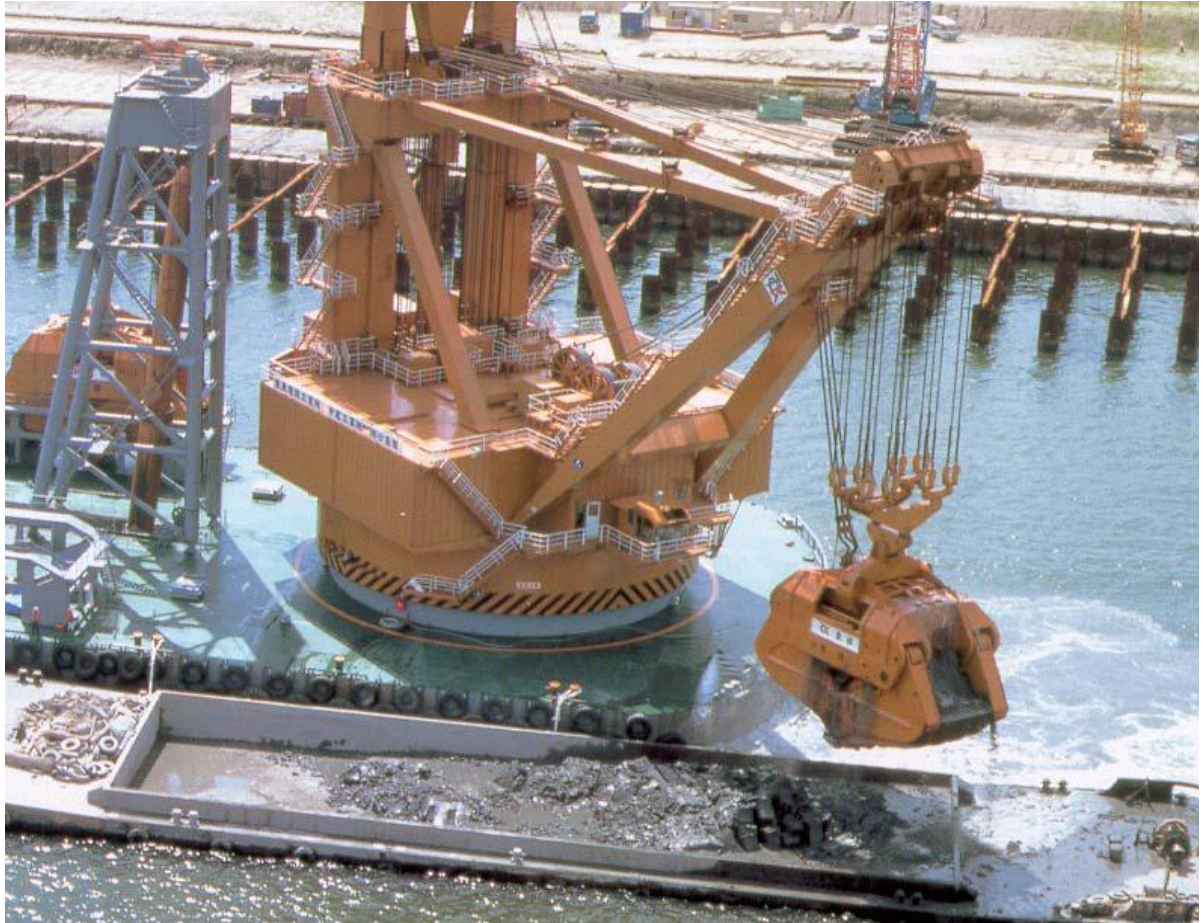
Figura 7. 15 – Draga Toshō en operación
